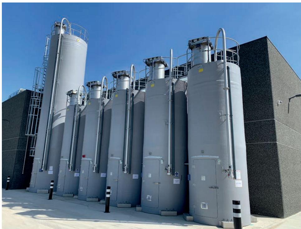
Afb. 2 Zes silo's voor de opslag van meel en bloemsoorten
