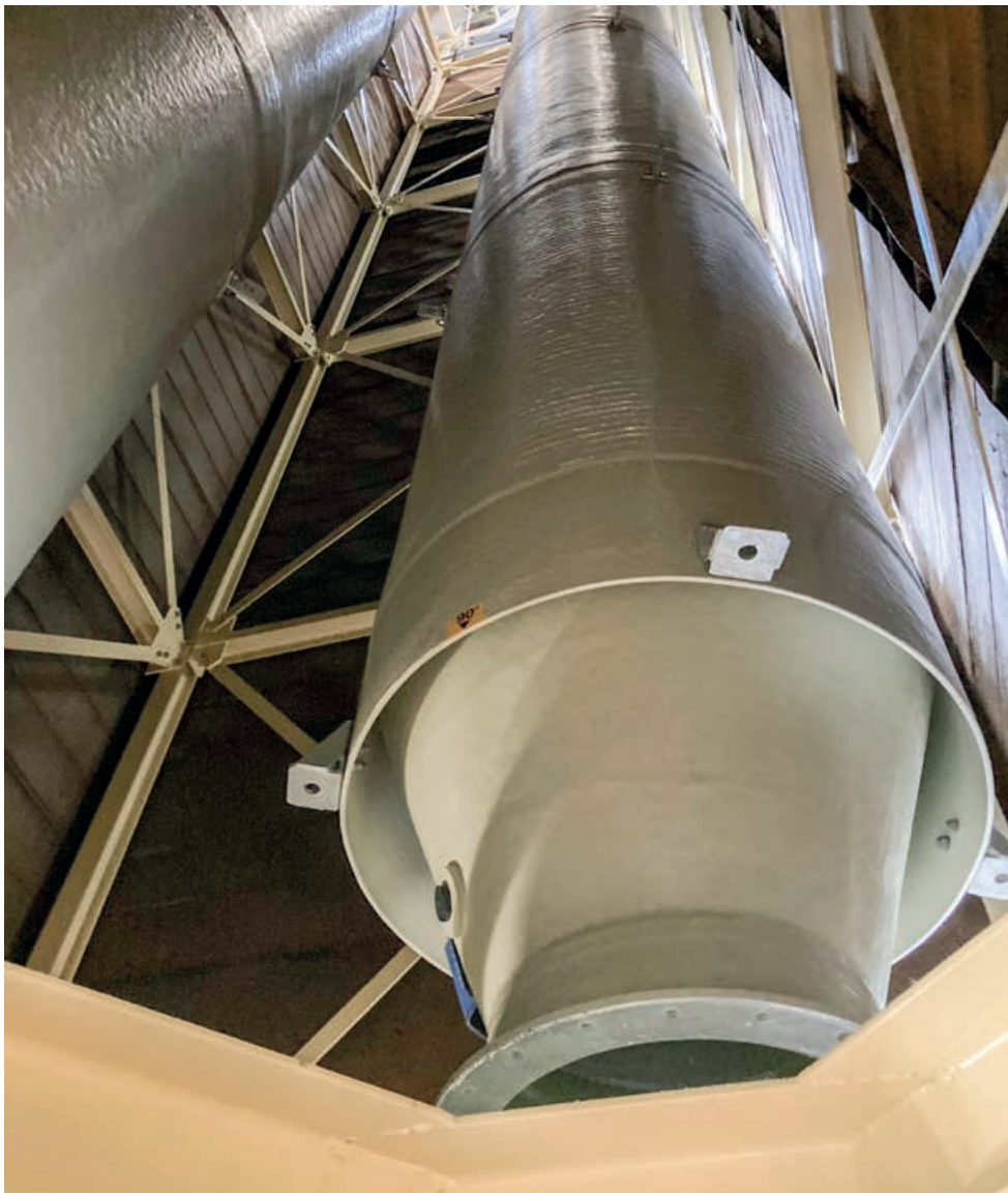
Het plaatsen van een aantal ronde polyester silo's binnen de kaders van de vierkante silo bleek de beste oplossing.
